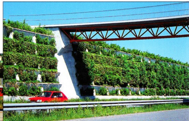
...stäbliche, leicht wirkende, durch rote Farbgebung betonte Fachwerk-Konstruktion mit schlanker Massivplatte; unauffällige Auflagerung auf der Stützmauer
