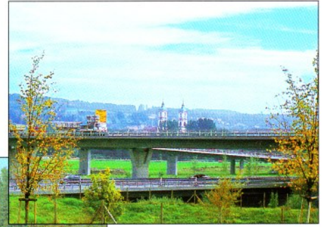
„Transparente“ Bauwerke anstelle von Dämmen: Blick zur Klosteranlage Weißenau
