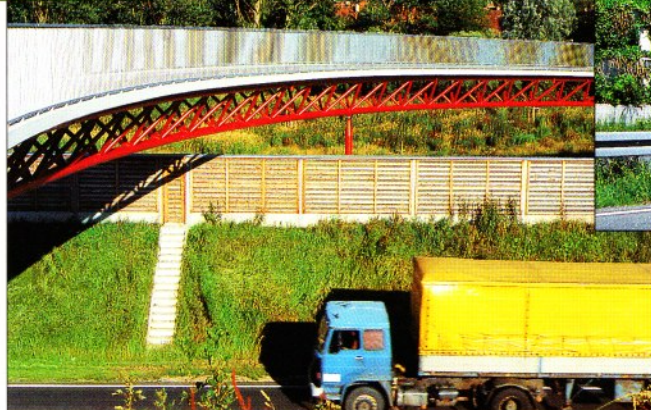
...auf der Talseite standortgerecht bepflanzter Wall mit aufgesetzter Lärmschutzwand aus Holz
