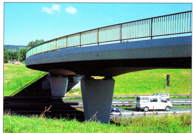
Geschwungene Friedbergzufahrt – durchlässig gestaltete Talquerung ohne Stützen im Mittelstreifen der B 30 mit breitem Sichtfeld für die Autofahrer
