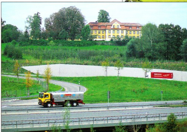
Stützmauer an den Rablenhofweibern – von den Landschaftsplanern in der Erscheinung bewußt als technisches Bauelement belassen
