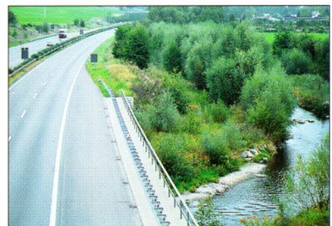
Bereits eingewachsen – die Schussen im neuen Flußbett nach den Vorstellungen der Ökologen
