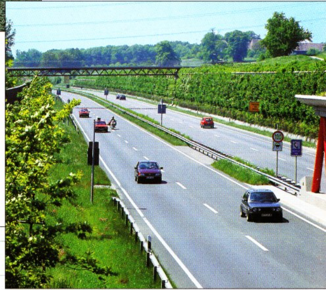
...total eingewachsene bangseitige Stützkonstruktion zur Abschirmung des Wohngebiets – ein weiteres prägendes Element der neuen B 30.
