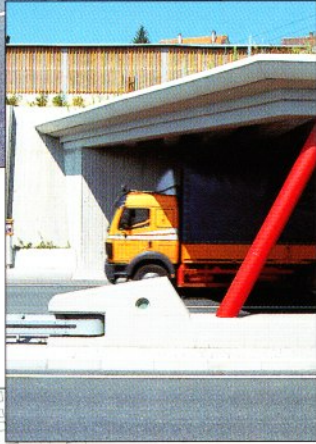
Südliche Galerieausfahrt mit Übergang zur Stützmauer und „Schlangenkopf“ am Mittelstreifen – sorgfältig gestaltete Details
