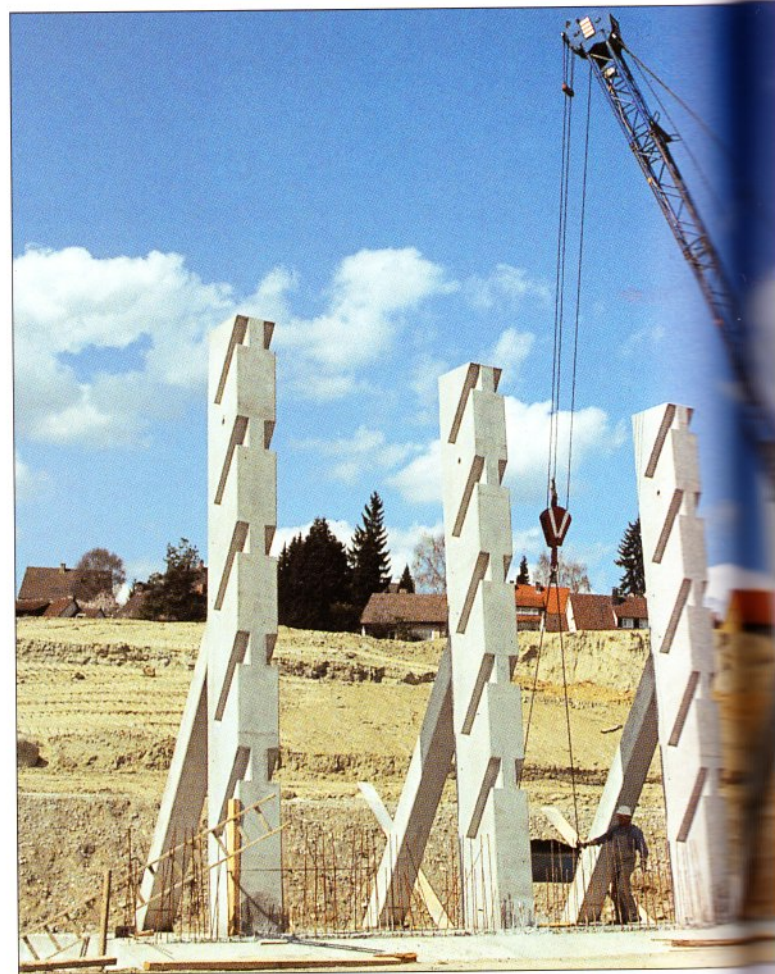
Die Stützkonstruktion entsteht.
