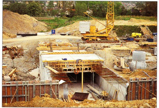
Der Höllbach-Durchlaß im Bau: Gewährleistet sind ausreichende Belüftung und Lichteinfall.
