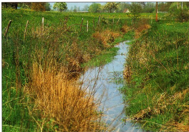
Der Wiesentalgraben vor der Baumaßnahme.
