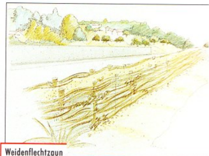
Weidenflechtzaun östlich der B 30.
