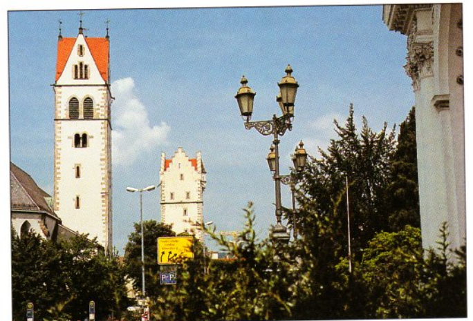
Die Ravensburger Türme als Vorbild bei der Gestaltung der Lärmschutzbauwerke.
