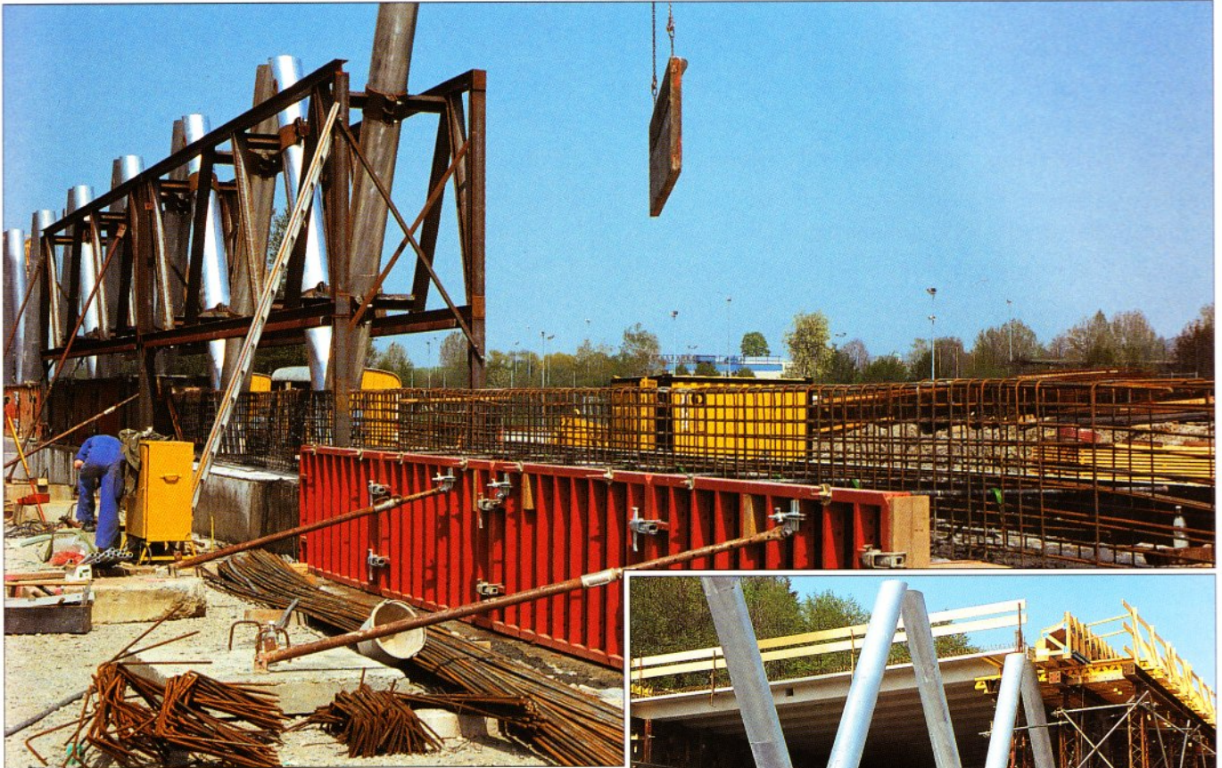
Die stählernen Diagonalstützen...
