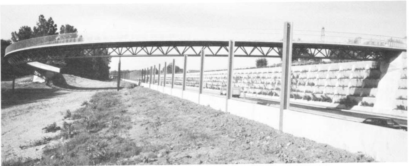
ausgreifendem Bogen die B 30 und die Schussentalau. Dieser Steg mit durchlaufendem Dreiecksfachwerkträger wirkt besonders ansprechend durch seine leichte stählerne Unterkonstruktion in rot wie die V-förmigen Diagonalstützen der Galerie. Die Leichtigkeit des Bauwerks wird durch die grazilen Lagerstützen und die unauffällige Auflagerung im Bereich der Lärmschutzwand unterstrichen.
